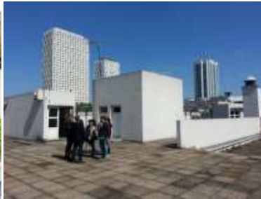
le toit du collège
