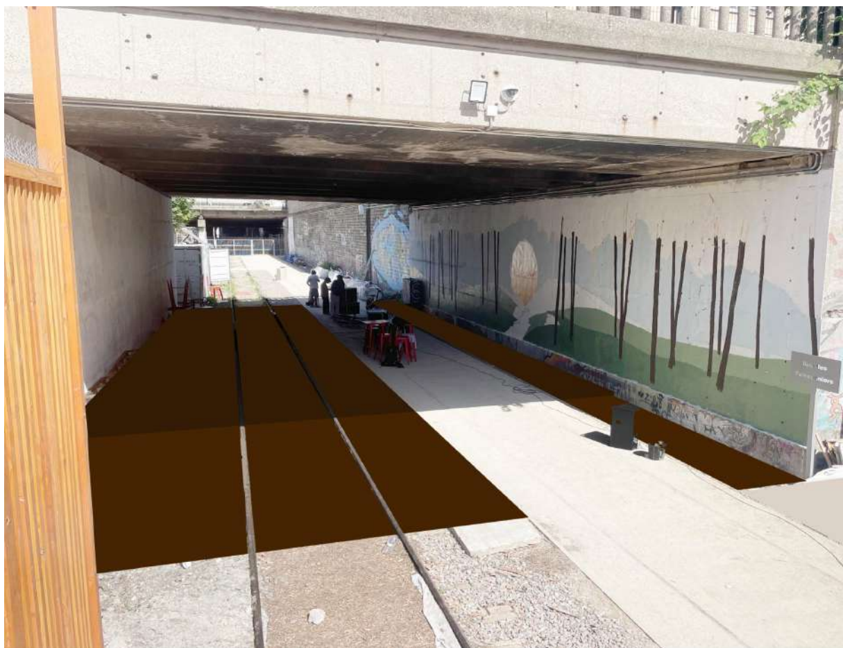
Platelage bois sous le pont
